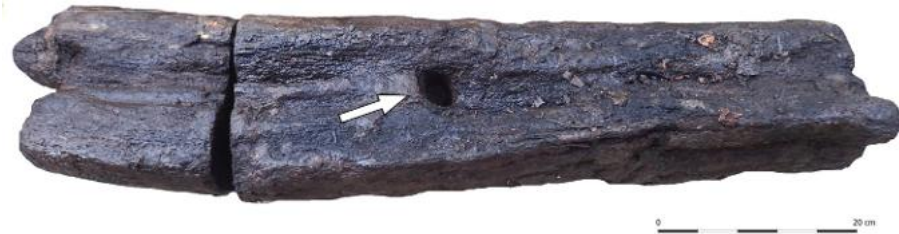
Afb. 5.126 Funderingsbalk (V383) met een doorboring (zie pijl). Foto: P. Doeve.
