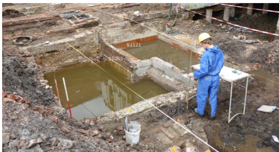
Afb. 4.111 Het onderkelderde achterhuis van Aalmarkt 15. De kelders kwamen tijdens het veldwerk blank te staan na drie dagen onafgebroken regenval. Maar ook daarna zou het droogpompen van de kelders door snel opkomend grondwater zeer moeizaam verlopen.
