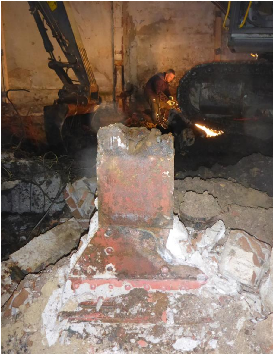
Afb. 4.113 Onderzijde van een staander van het staalskelet van het zogenoemde Van Nelle-pand (S8087). De dicht gevlochten staalkabels in het gewapende beton zorgden ervoor dat de funderingen lastig te verwijderen waren. Op de achtergrond is de graafmachinist bezig om met een snijbrander de in de rups vastgelopen wapening los te krijgen.
