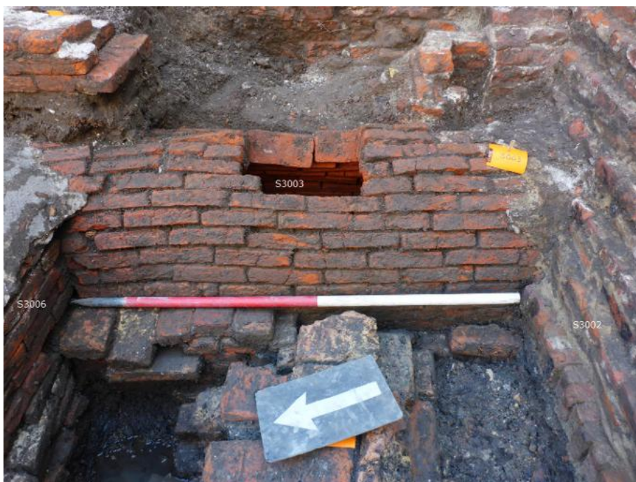
Afb. 4.91 Detailopname van de gewelfde goot in de achtertuin van Breestraat 70, op het tracé van de voormalige Zonneveldpoort (S3003). De archeologen hebben enkele stenen uit de kruin van het gewelf verwijderd om een kijkje te nemen in het inwendige van de goot. De fundering rechts (S3002) behoort tot de in 1922 gebouwde drukkerij. Bij de bouw is de goot intact gelaten.
