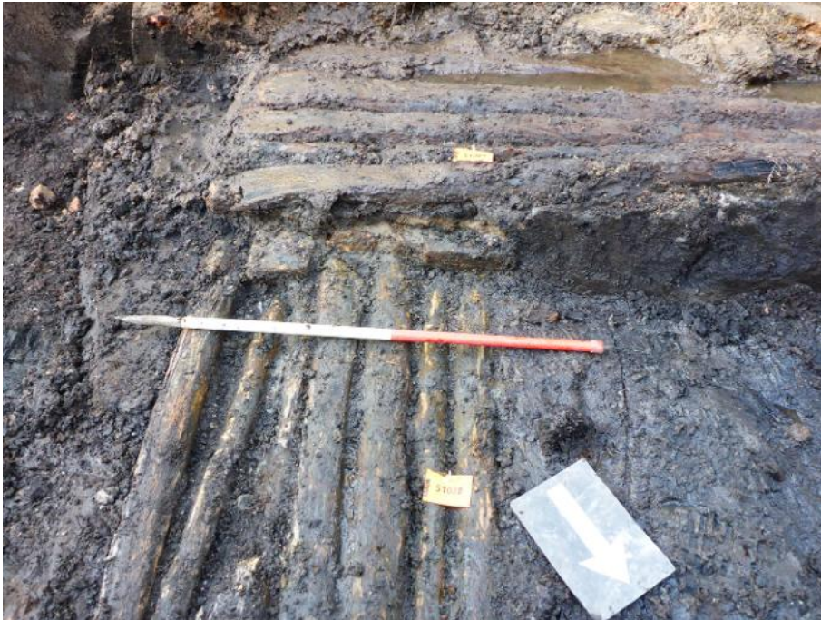
Afb. 4.48 Detailopname van de slietenfundering van het achterhuis van Aalmarkt 12/13, ter hoogte van de zuidelijke hoek van het gebouw.
