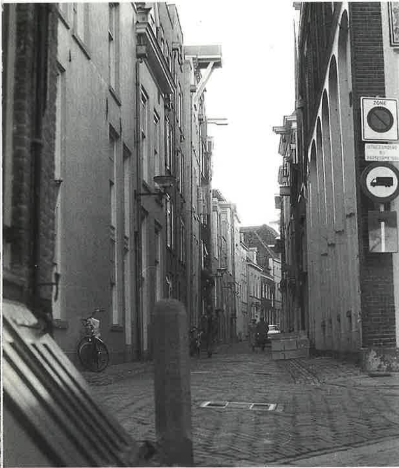
Gezicht vanuit de Zandstraat in de gerestaureerde Assenstraat, september 1988. Foto F.D. Zeiler.
