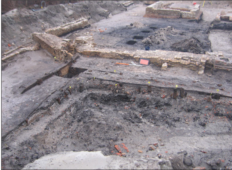
Afb. 2.13 Houten beschoeiing gezien vanuit het noordoosten met daarachter fundering S4009 en goot S4008 en S4010.
