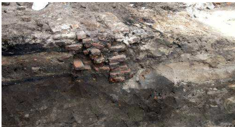
Afb. 34d: Doorsnede door fundering 4E die direct op 3E is gebouwd (vgl. afb.6 profiel CD)
