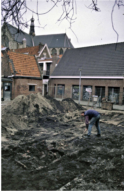
Afb.47a-b Funderingen uit de 19de en 20ste eeuw bij de Augustijnsteeg, gebouwd op een laag 19de-eeuwse tuingrond.
