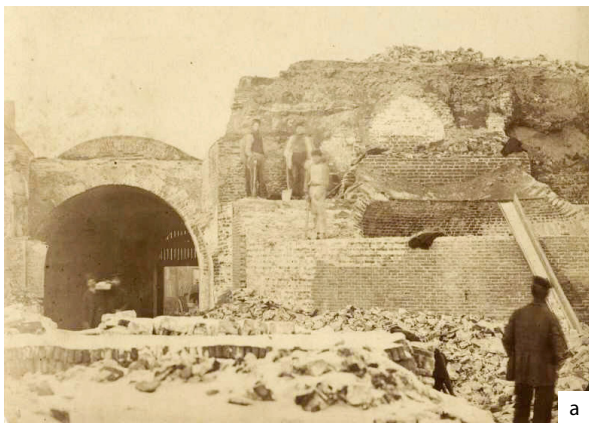
Figuur 6.11. Het slechten van de vestingwerken bij de Ziekerpoort omstreeks 1877–1879, gezien vanaf de veldzijde. a de poortdoorgang en restanten van het rondeel, b de afgepelde walmuur richting de Hertogpoort. RAN (F F68595/F 68600)
