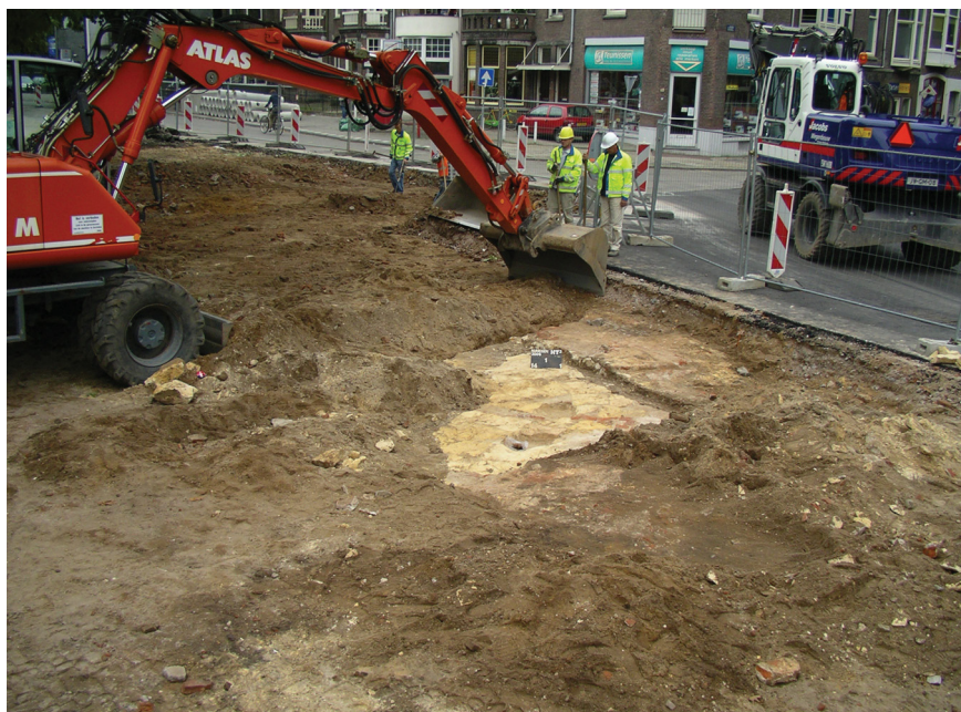
Figuur 2.3 De aanleg van het eerste vlak ter hoogte van het muurwerk van de Hertogpoort in werkput 14. RK
