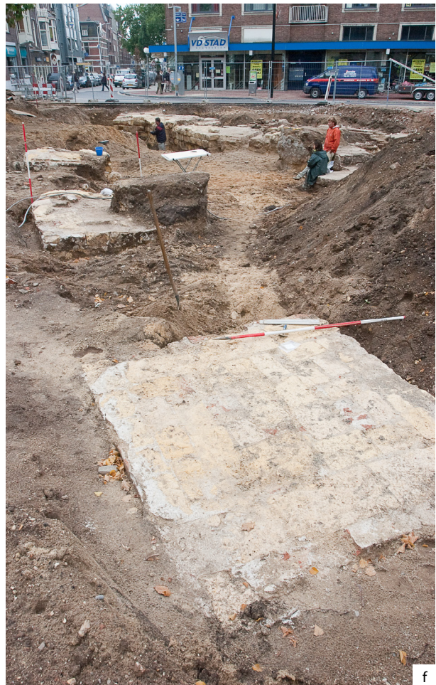
Figuur 5.9. Het muurwerk van structuur B. a noordwestelijk aanzicht poer B1, b zuidwestelijk aanzicht poer B2, c westelijk aanzicht poer B3, d noordwestelijk aanzicht poer B4, e zuidoostprofiel poer B5, na verwijdering van het aangetroffen muurwerk, f zicht op de poeren B2–B4 vanuit het noordoosten. WK/II/JO/RM
