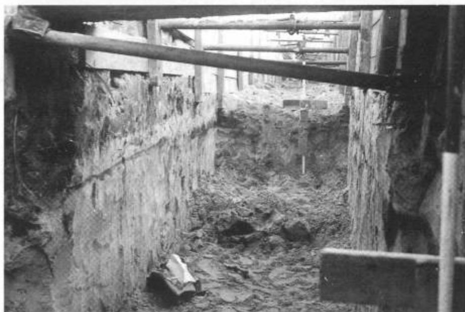
Afb. 16. Haarlem Nieuwe Gracht noordzijde bij nr. 102. Opbouw profiel in rioolsleuf met inschakeling van humeus bandje in duinzand.
