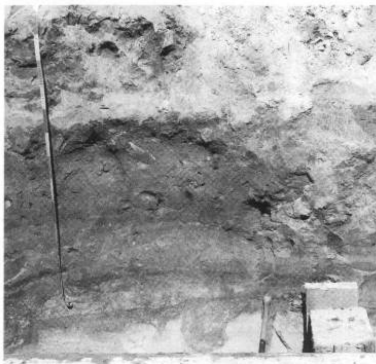
Afb. 25. Haarlem Grote Markt. Noordwand bouwput voor een brandblusinstallatie. Bovenste deel en plaats van het beschreven profiel (bijlage en afb. 23). Niet zichtbaar is de dieper gelegen in duinzand voorkomende veenlaag, waaraan pollen-analytisch en C14-onderzoek plaatsvond.
