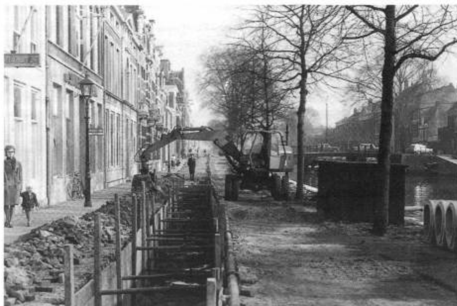
Afb. 15. Haarlem Nieuwe Gracht noordzijde tussen Nassau- en Kruisbrug. Overzicht rioleringswerkzaamheden februari 1964. Foto genomen ter hoogte van nr. 102 (nabij de Nassaubrug) in de richting van de Kruisbrug.
