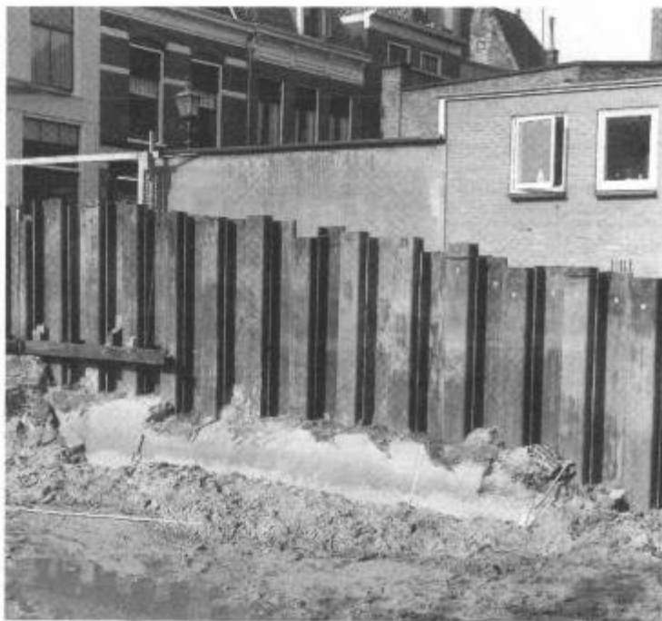
Afb. 12. Korte Jansbrug. Overzicht ontgraving met onder de damwand de in duinzand ingeschakelde donkerder gekleurde prehistorische woonlaag. Links de voorgevels van de panden aan de zuidzijde van de Korte Jansstraat. (zelfde foto als in De Jong, 1971, p.132).
