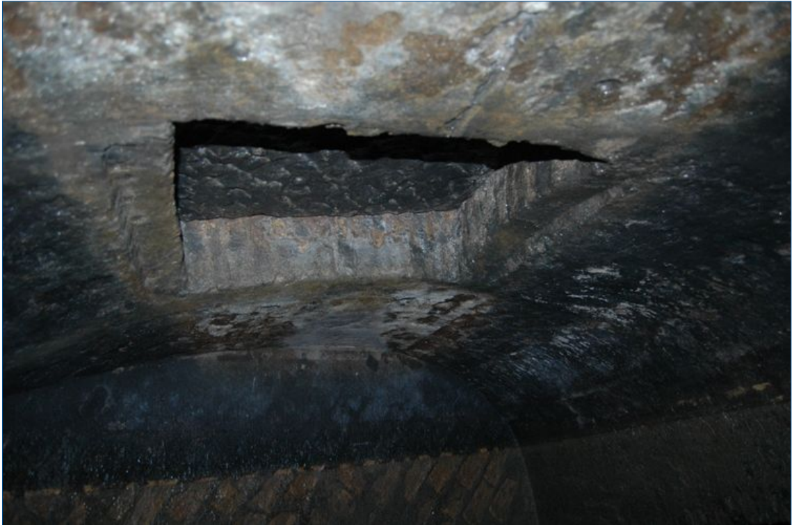
Figuur 9.5. Het zuidelijke luik in het plafond, gezien vanuit de kelder (foto: Vanoverbeke, 2010).
