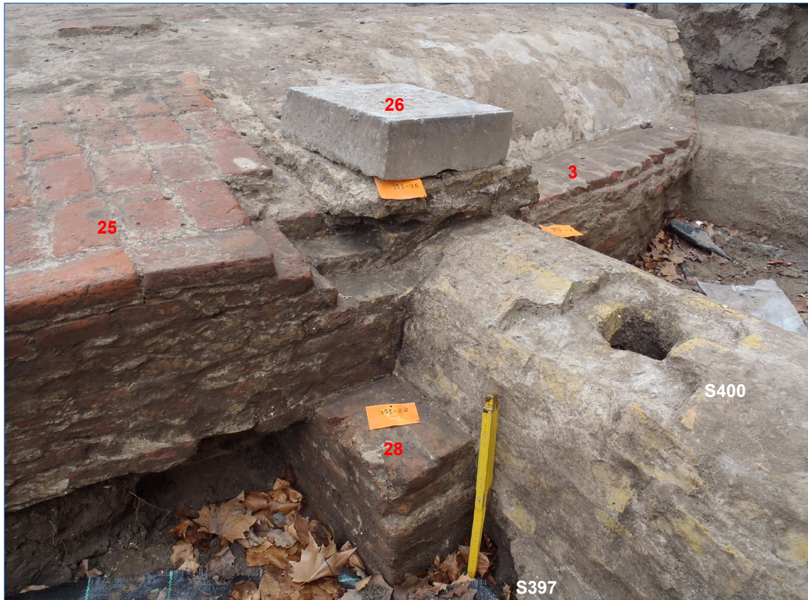
Figuur 9.15. Aansluiting inlaat of overloop (S400/S397) op de cisterne. In rood: de vullingsnummers.
