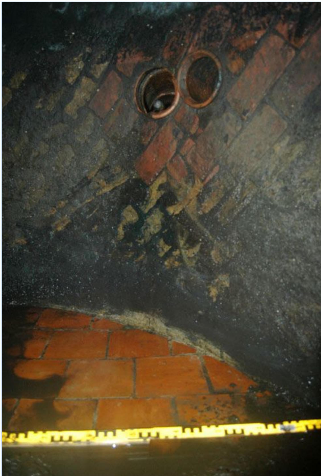
Figuur 9.4. De vloer en twee gaten ten behoeve van inlaten (foto: Vanoverbeke, 2010).
