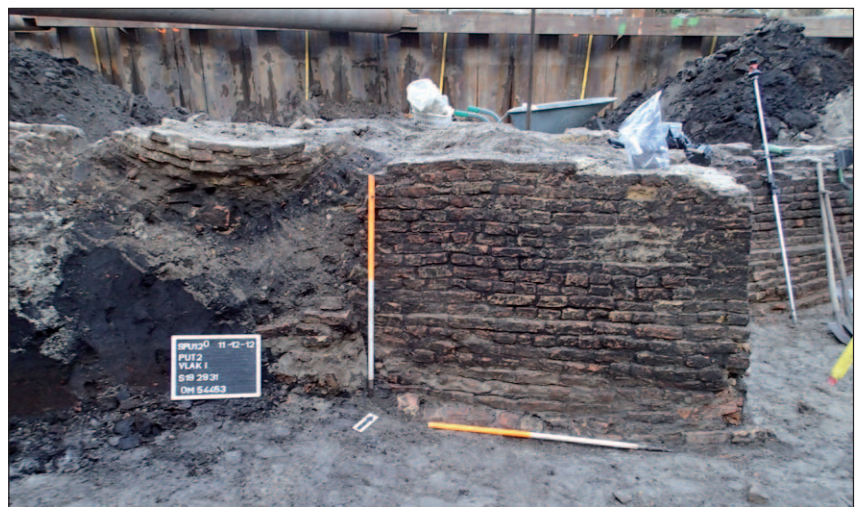
Afb. 5.14 Bij de aanleg van waterput spoor 29 (bakstenen putmantel bevindt zich boven het fotobord) werd de zuidoost hoek van de kelderstructuur spoor 19 – rechts op de foto - gesloopt.
