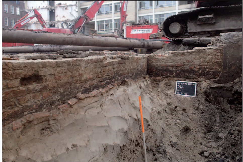
Afb. 5.6 Muurfundering (spoor 24) uit de 15de eeuw met schief verzakte onderste rij bakstenen.
