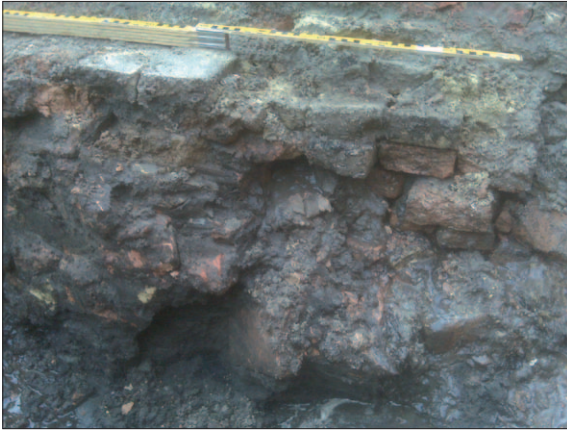
Afb. 5.4a Funderingsresten uit de late 14de eeuw ter hoogte van Spui 26 tijdens waarneming bij graven sleuven voor de damwand van de bouwput.
