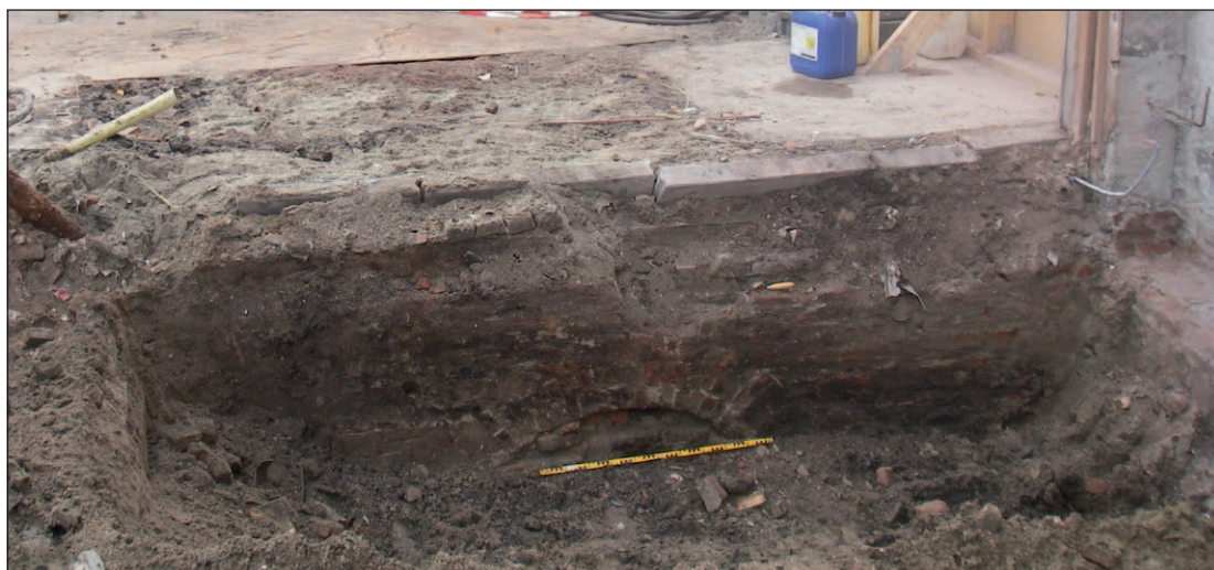
Afb. 5.2 Spaarboogfundering ter hoogte van de voorgevel van Spui 24.
