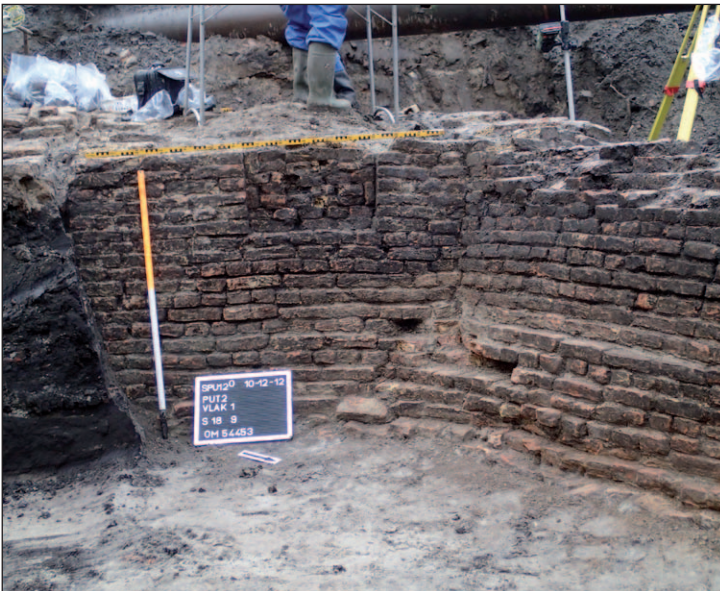
Afb. 5.11 Noordwand van (beer)kelder spoor 19 met dichtgezette opening.
