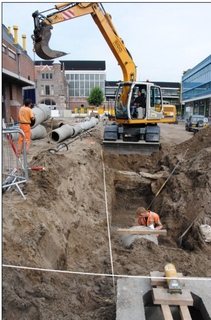
Afbeelding 12. Medewerkers van Heijmans bereiden de plaatsing van een nieuw segment van het riool voor. Kijkrichting: noord.
