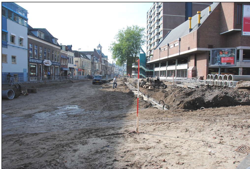
Afbeelding 2. Het plangebied (kijkrichting: zuid) vóór aanvang van de archeologische begeleiding. De nieuwe riolsleuf (werkput 1) werd langs de linkerkant van de bronbemaling aangelegd.
