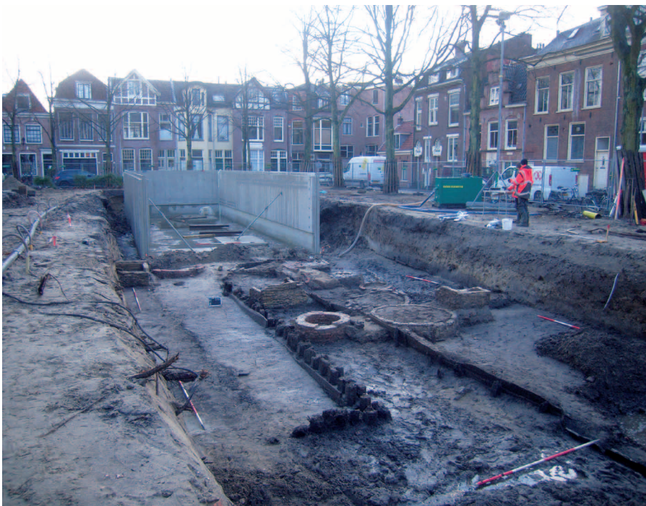
Afb. 14 Overzicht van het westdeel van de opgravingsput, vlak 1, na plaatsing van het eerste deel van het rioolbezinkbassin.
