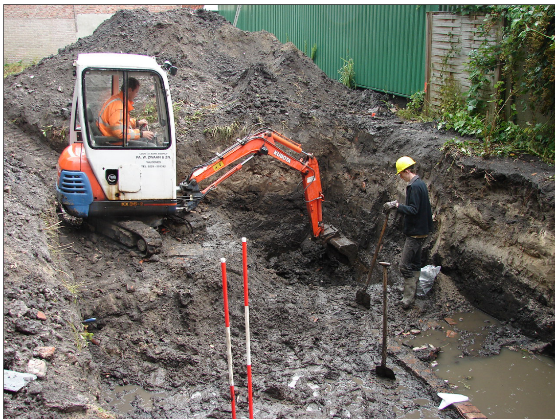
Afbeelding 11. Eén van de beperkingen: verdiepen met een kleine graafmachine
