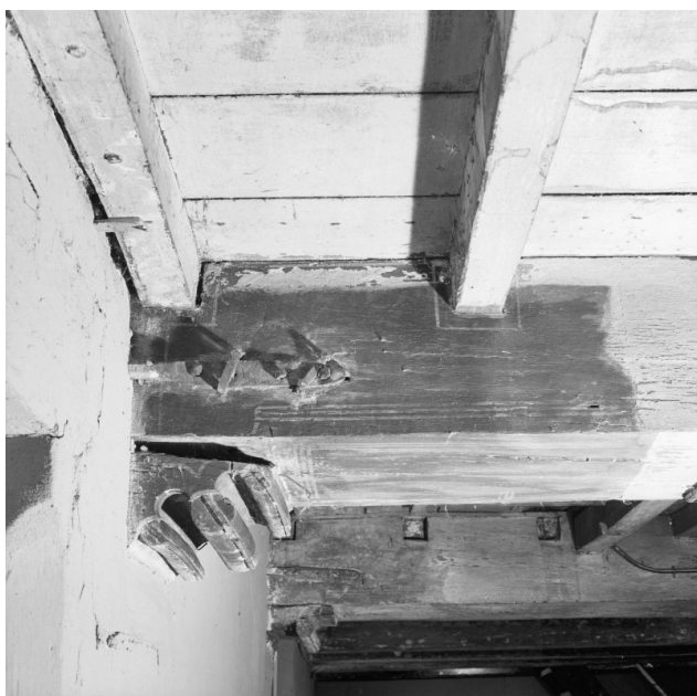
Afb. 4.3. De consoles met drie peerkralen en een neuslijstje (Foto A.J. van der Wal, 1986, Collectie Rijksdienst voor het Cultureel Erfgoed, obj.nr. 263.159).
