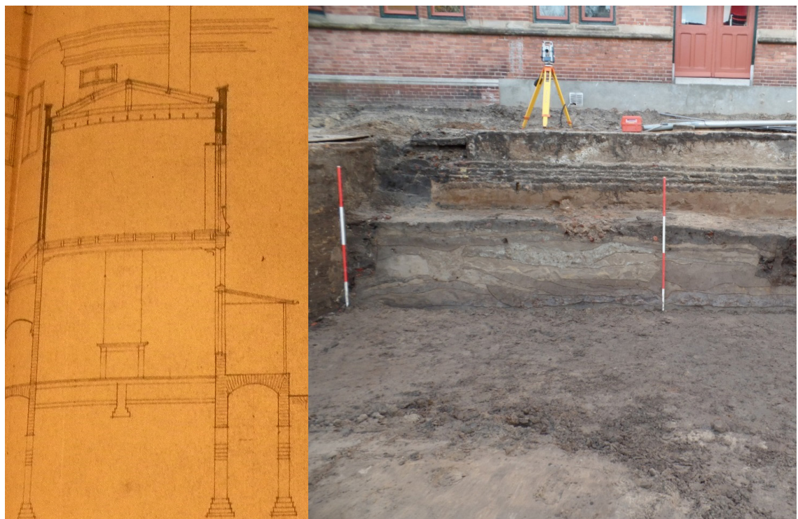
Afb. 5.15. Bestektekening uit 1979 met de nieuwe situatie van de serre (links). Foto van de fundering van de serre (rechts).
