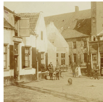
afbeelding 84, foto van de Appelmart uit circa 1900 met daarop de schaduw van de telefoonmast die in het centrum van het plein heeft gestaan.
