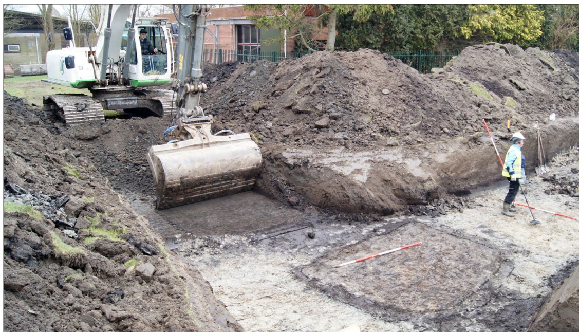
Afb. 24 Een grote kuil/daliegat op de kruising van werkput 1 en 2. De foto is richting het noordwesten genomen.
