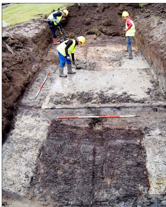
Afb. 74 Aanleg werkput 1. Zichtbaar zijn de met zand gevulde betonnen bak van de meeste recente insteekhaven, met daarvoor (bruine baan) een deel van de middeleeuwse sloot.
