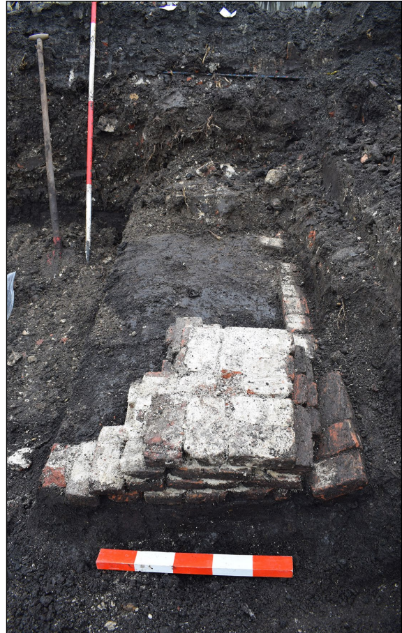
Afb. 4.28. De resten van een vermoedelijke schoorsteenfundering.
