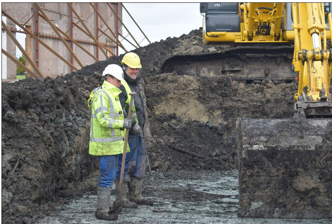
Afb. 1.2. Het archeologisch leesbare vlak wordt met een graafmachine aangelegd.
