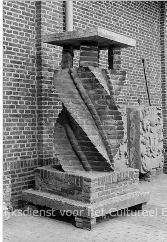
Afb. 144 Getordeerde schoorsteen van een huis in de Narmstraat in Leiden. Foto: Rijksdienst voor het Cultureel Erfgoed.
